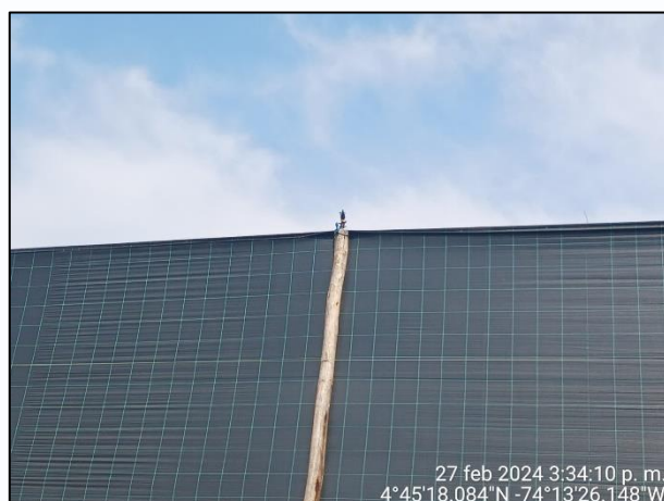
Ilustración 2. Aspersores de agua en el cerramiento del predio
